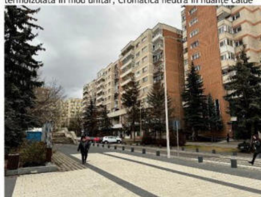
AȘA DA - Închiderea balcoanelor în mod unitar;
