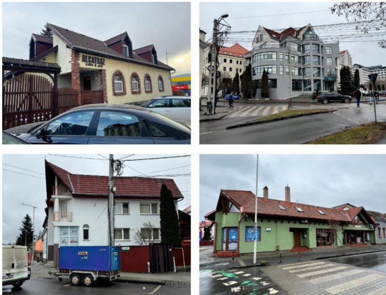
Figura 1 - Exemplu de fond construit care depreciază imaginea urbană prin gabarit și organizare spațial-volumetrică, sursa: autorii Studiului Istoric General (Logic Plan SRL)
